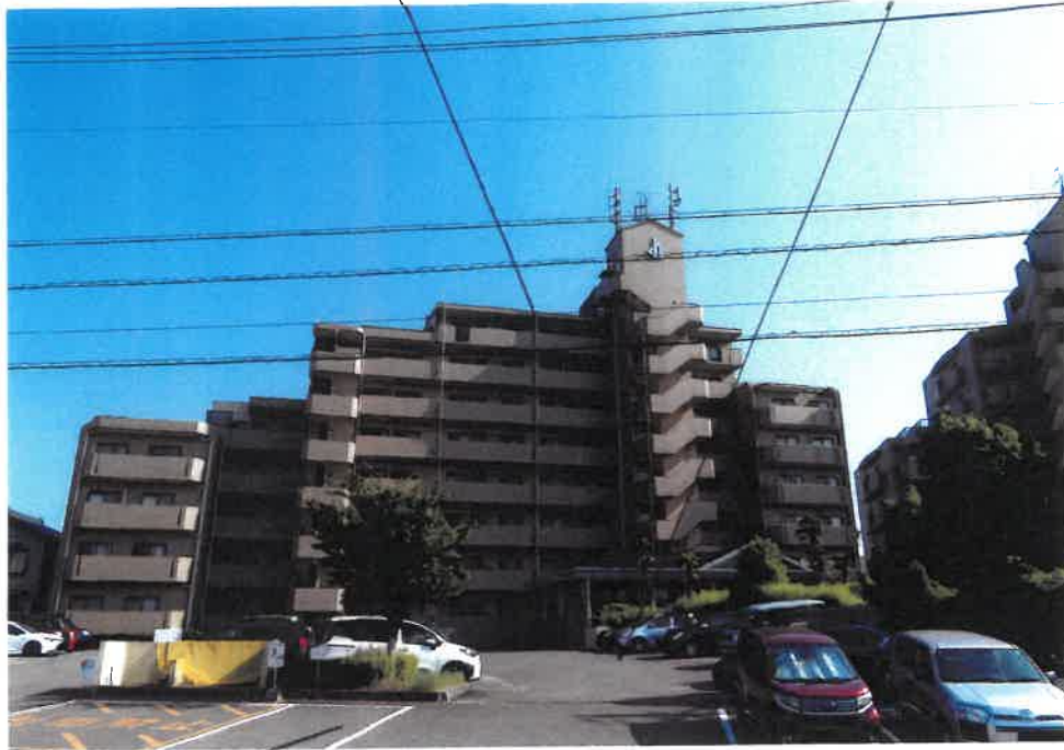
目的外土地（北側隣地地番12番5）の駐車場の様子 ① 北西方向から撮影
