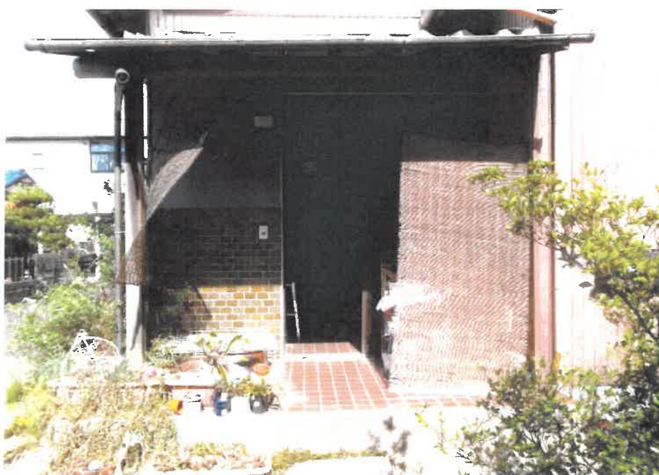
⑤ 物件2建物の玄関
