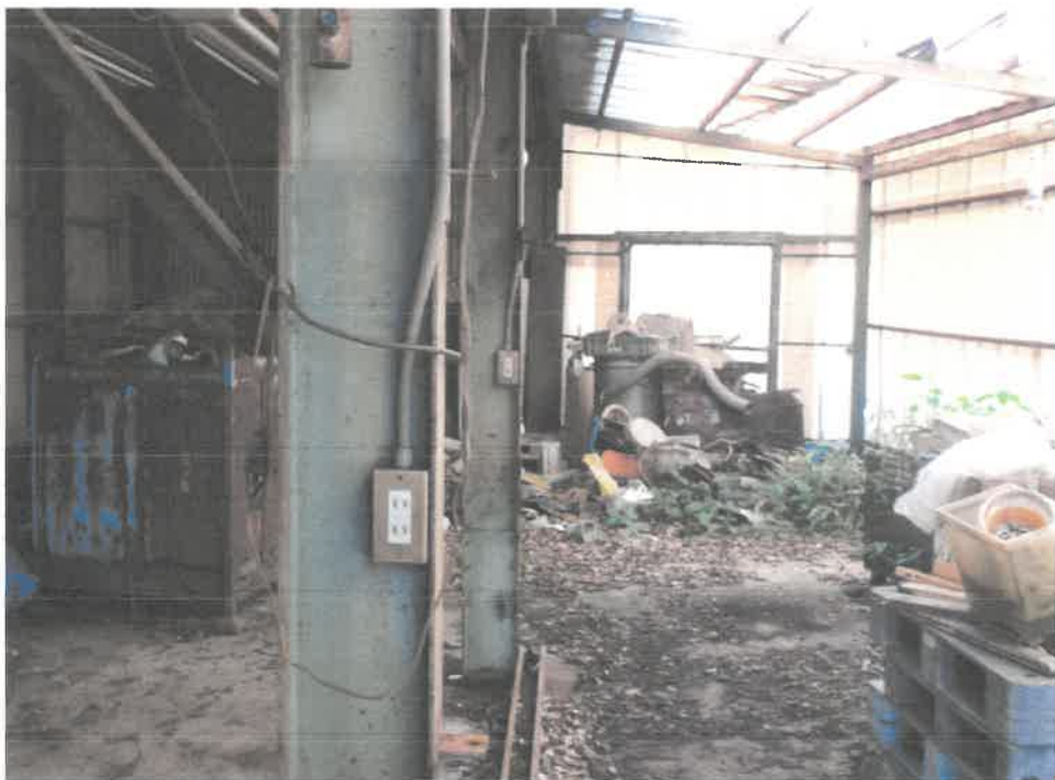
⑩-2 物件3建物及び目的外建物の状況
