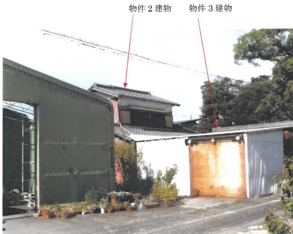
① 物件 1、4 土地を含む物件 2 建物、物件 3 建物の外観
