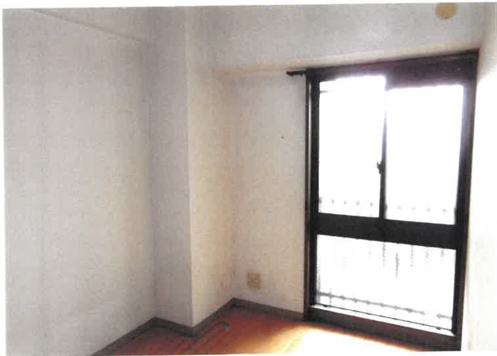
④ 屋内の状況 (洋室③)
