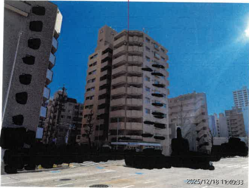
物件 2 建物を含む一棟の建物
