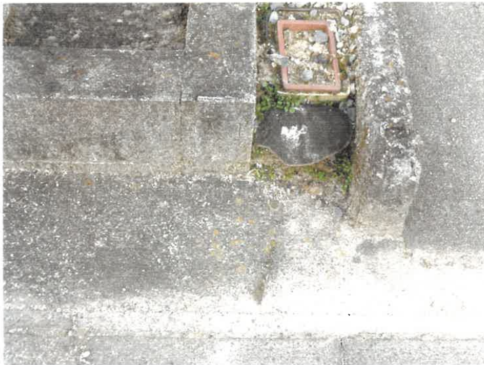
④ 物件1 土地南西境界付近の状況
