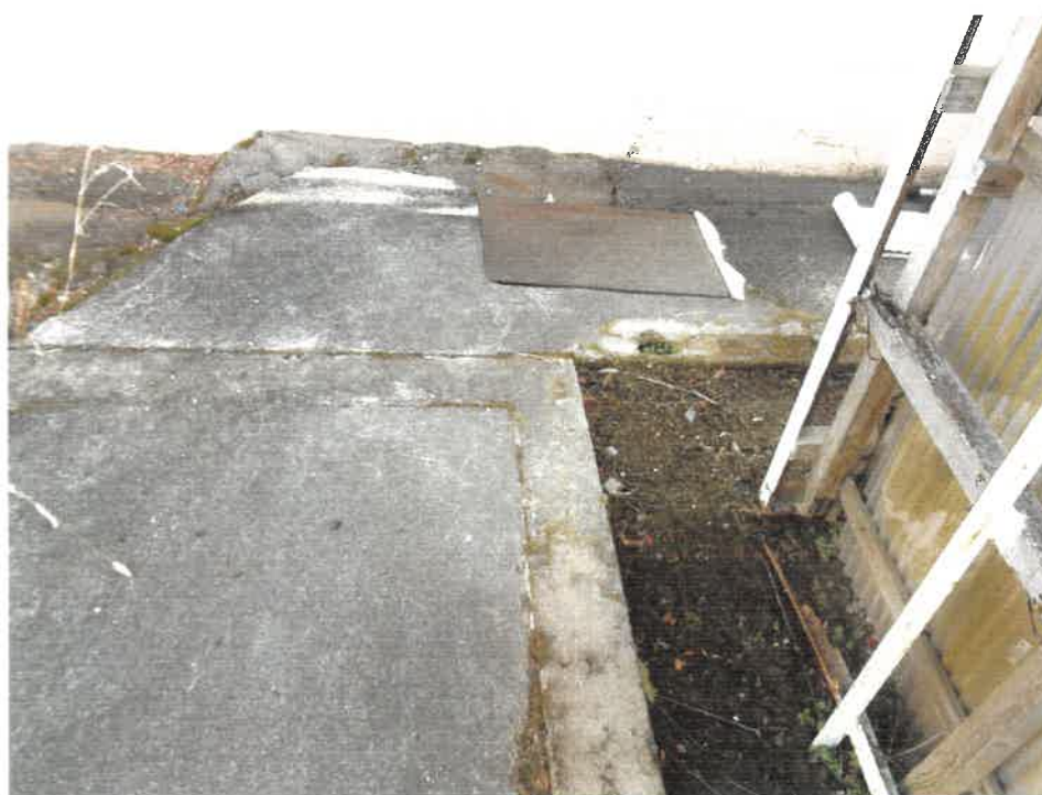
⑧ 物件1 土地南東境界付近の状況
