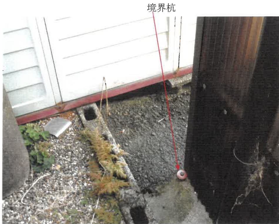
⑨ 物件1 土地北東境界付近の状況
