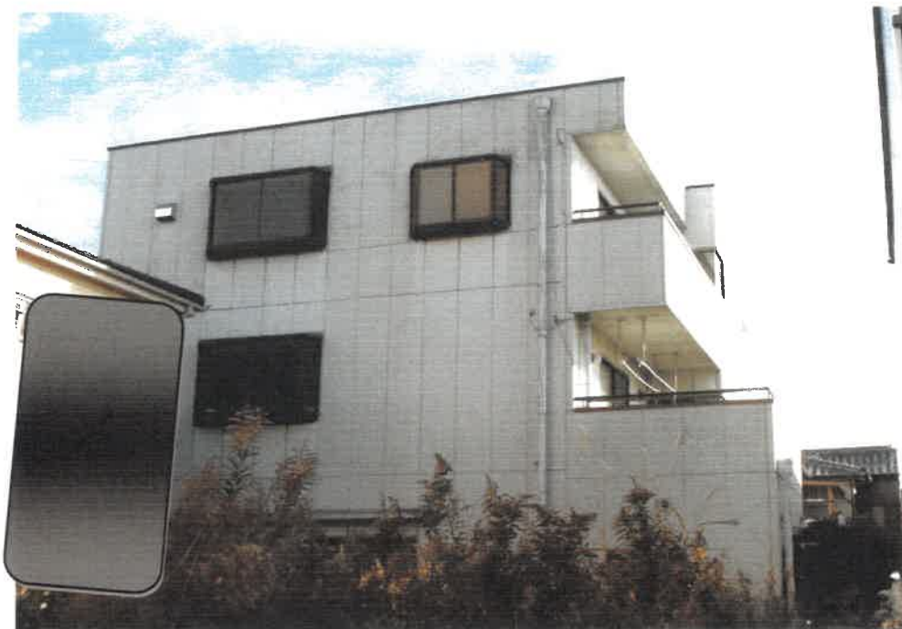
③ 物件4 建物の外観
