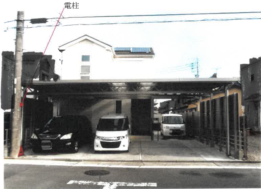
① 物件1土地、物件2土地を含む物件3建物の外観
