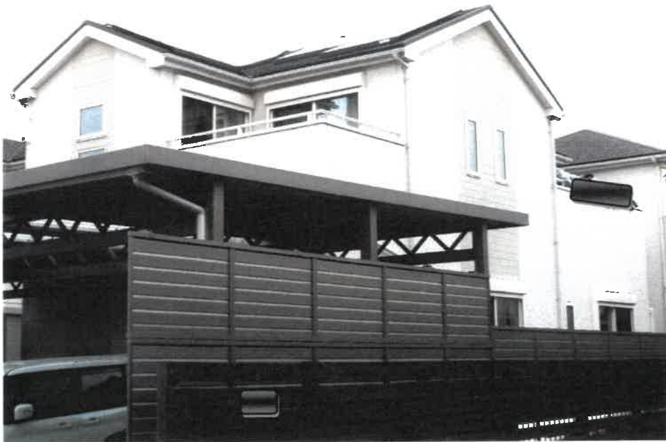
② 物件1土地、物件2土地を含む物件3建物の外観
