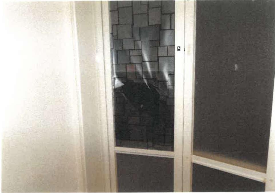
⑦ 浴室の扉の補修の状況
