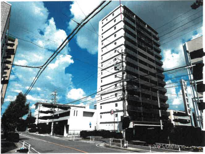
物件1 建物を含む一棟の建物 (プライムスイート建中寺)
