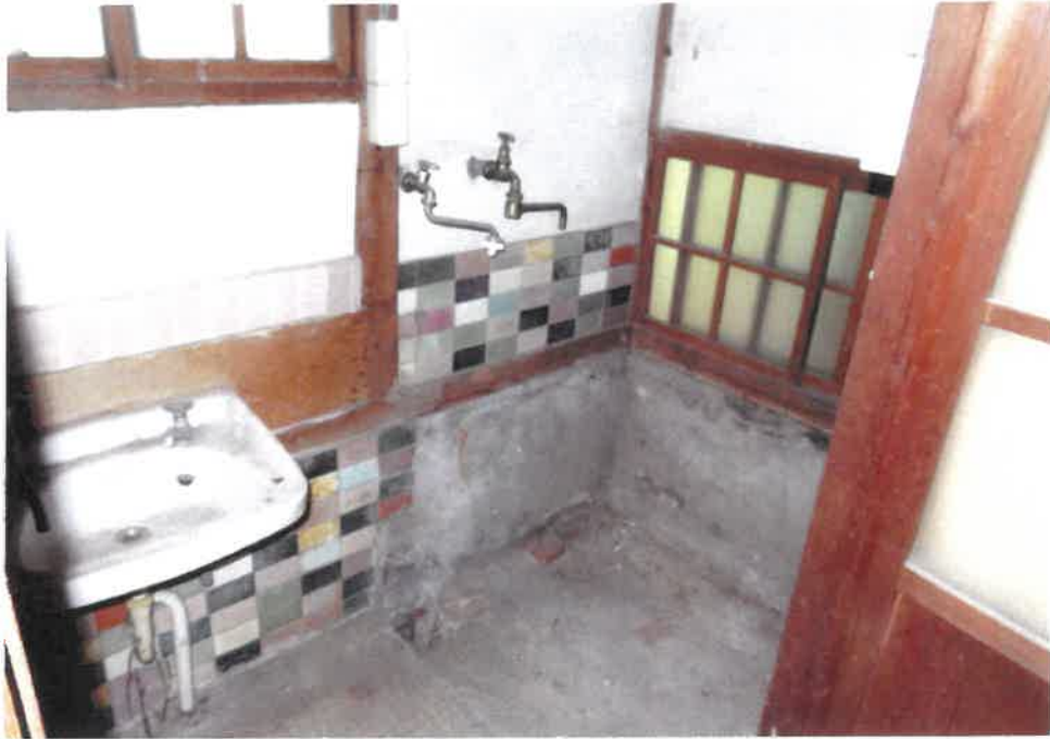
⑪ 屋内の状況（物件14主である建物洗面所）
