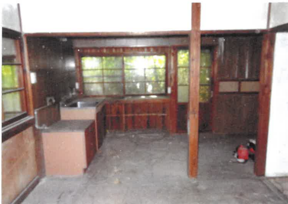
⑨ 屋内の状況（物件14主である建物キッチンの様子）
