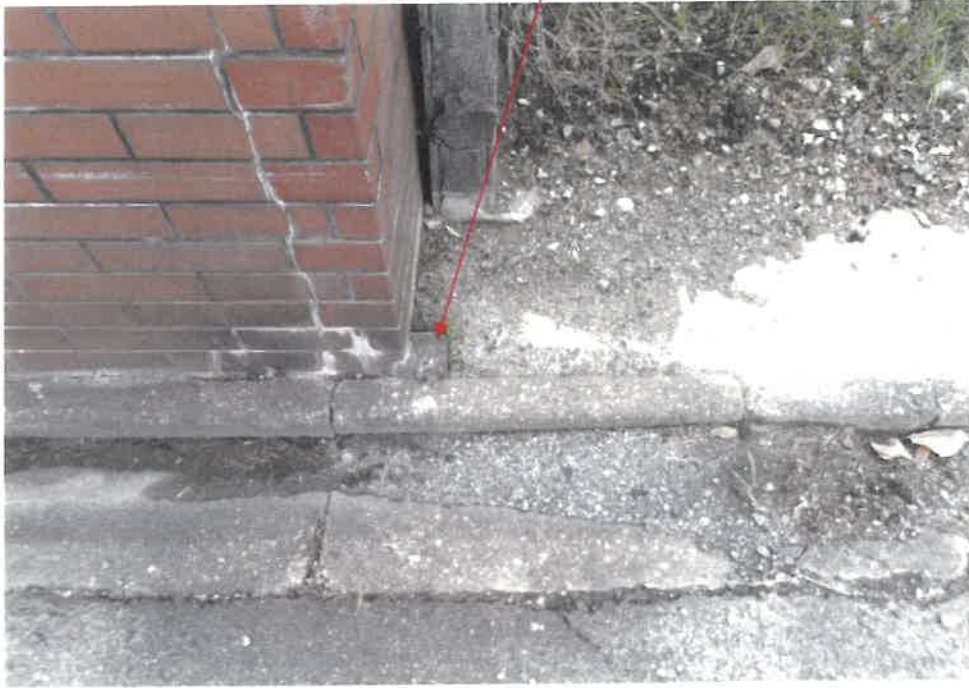
③ 物件4 土地旗竿地北東の境界の状況
