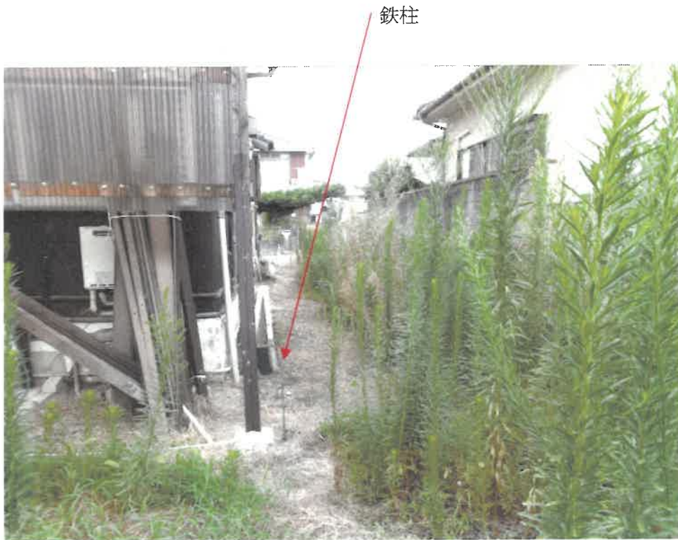
⑧ 物件4 土地旗竿地西側の状況
