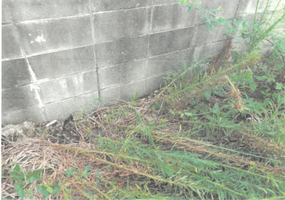
⑬ 物件4 土地旗地南西の境界付近の状況
