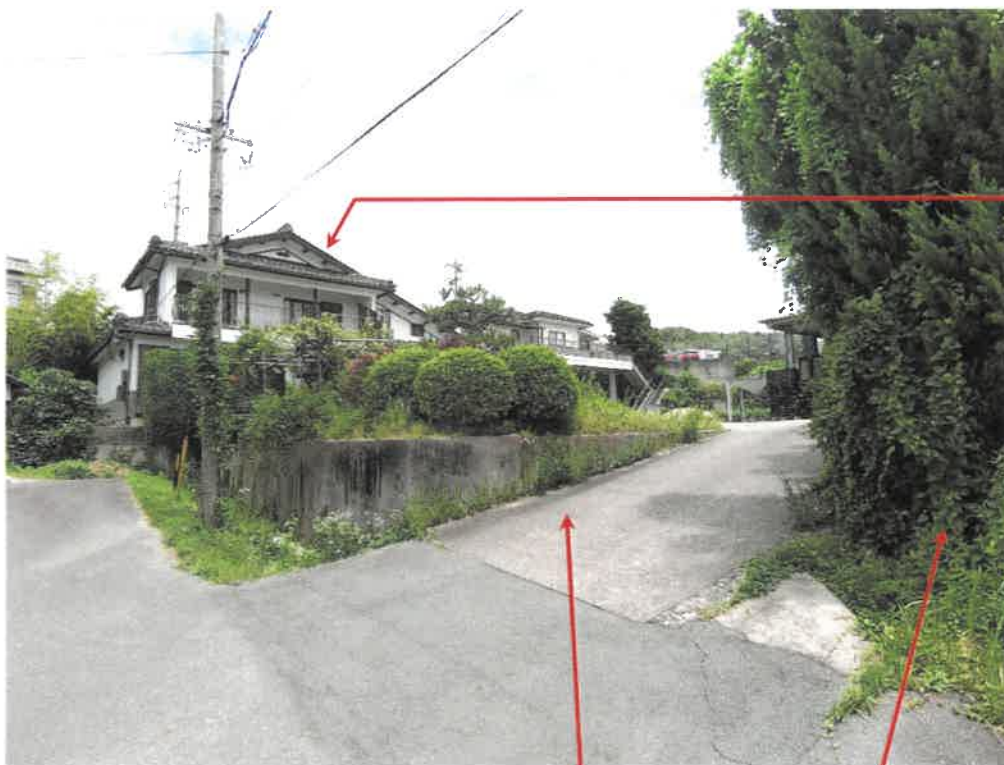
1 物件3土地及び物件4建物の外観（南西方向から撮影）
