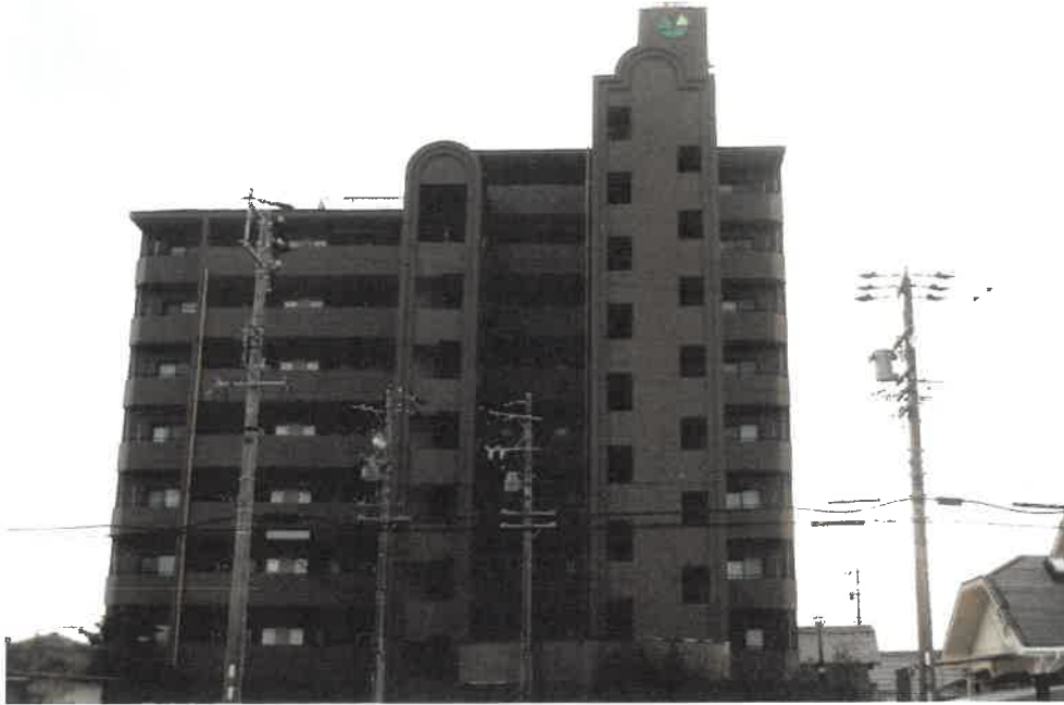
① 物件1 建物を含む一棟の建物の外観
