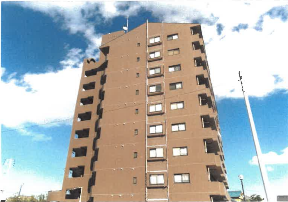
② 物件1 建物を含む一棟の建物の外観
