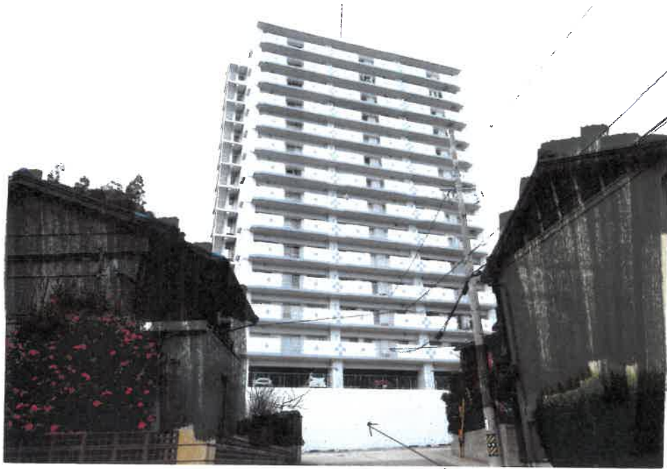
駐車場への進入路
