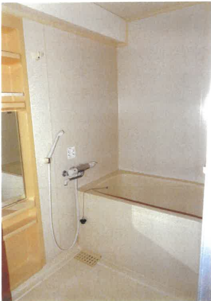
⑥ 屋内の状況（浴室）
