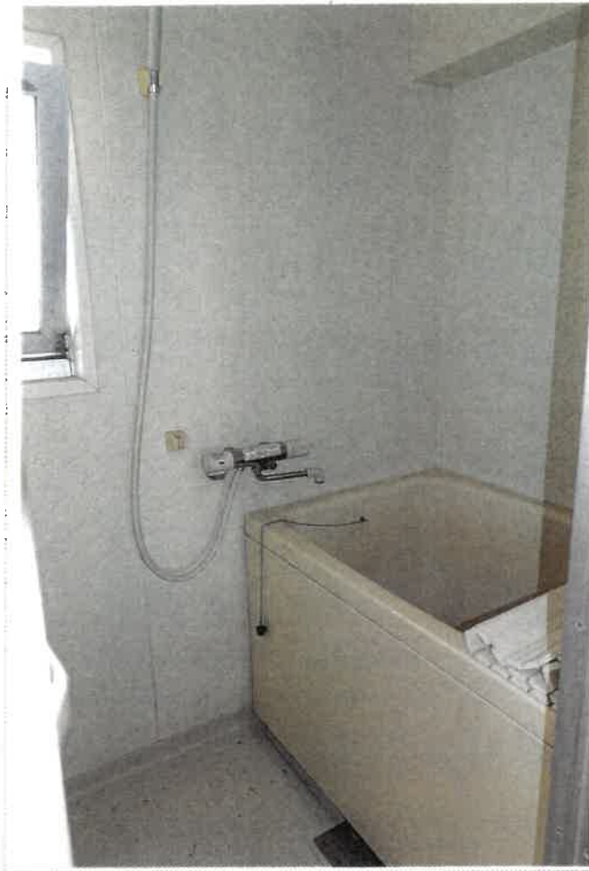
13 屋内の状況（浴室（6-B号室））
