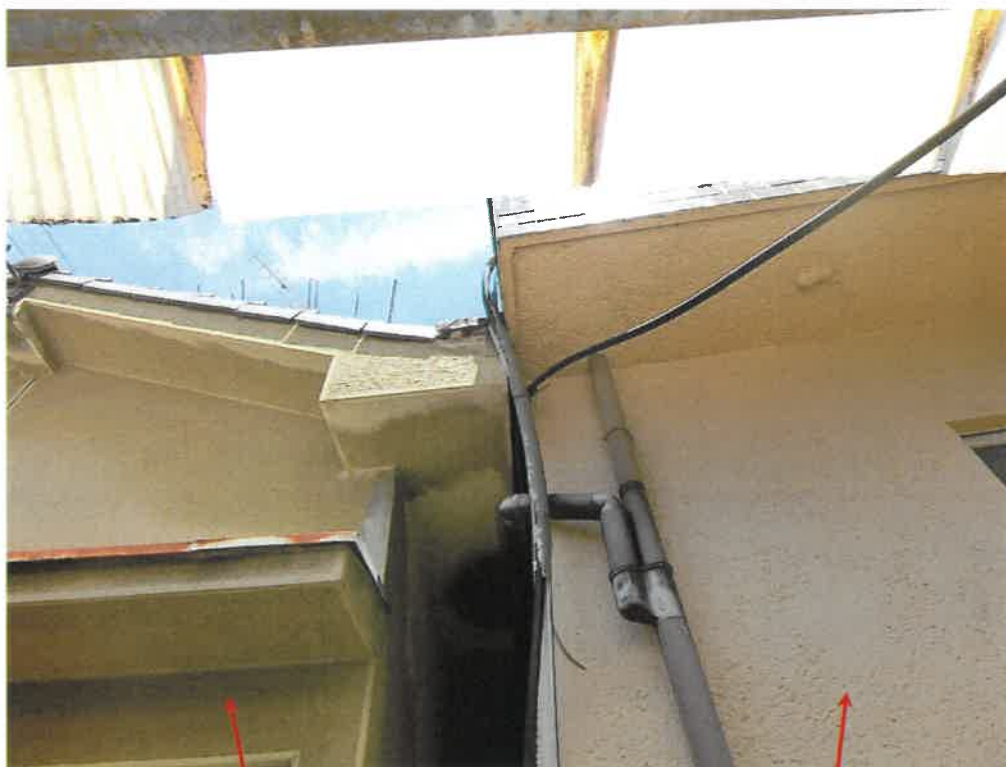
物件3附属建物2
