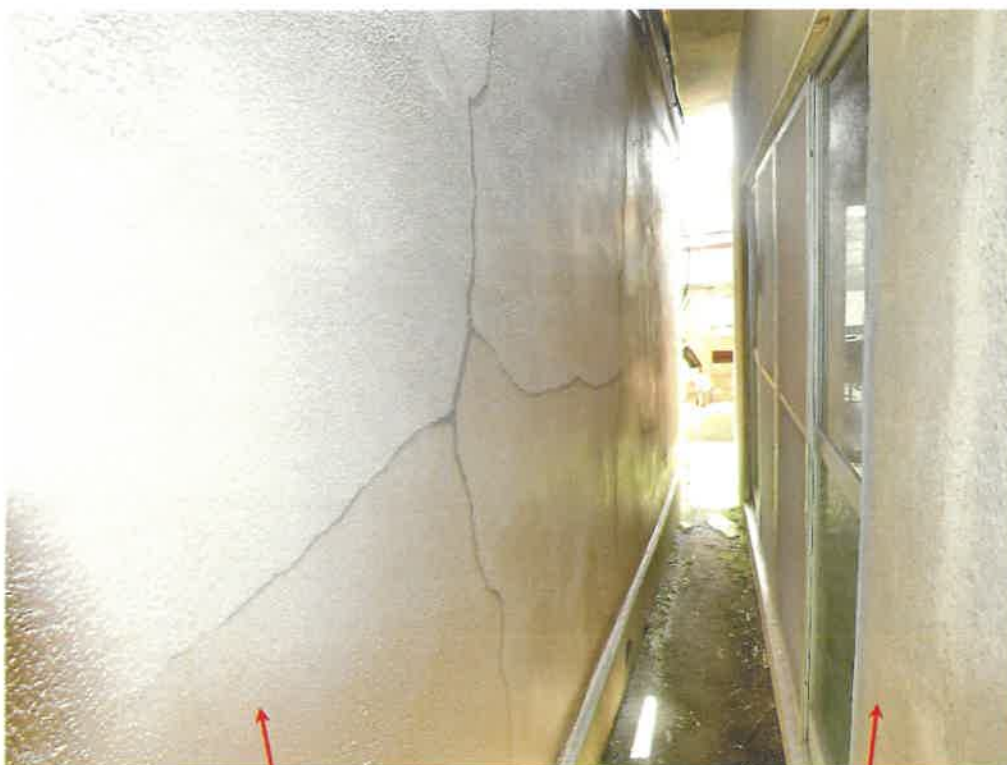
物件3主である建物
