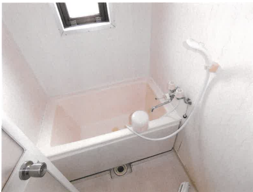
1 1 物件2建物内部の状況（N棟204号室・浴室）
