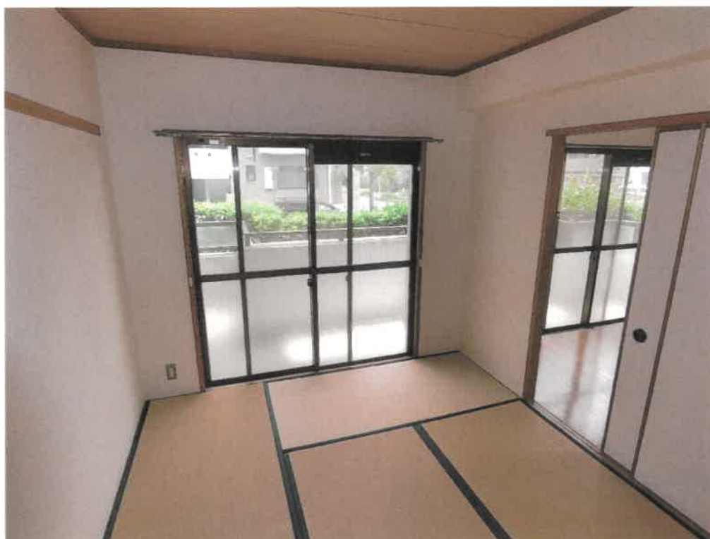
6 物件2 建物内部の状況（N棟104号室・和室）
