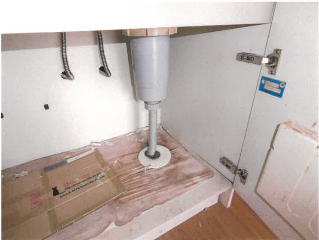
2 2 物件3建物内部の状況（S棟303号室・キッチンシンク下部）
