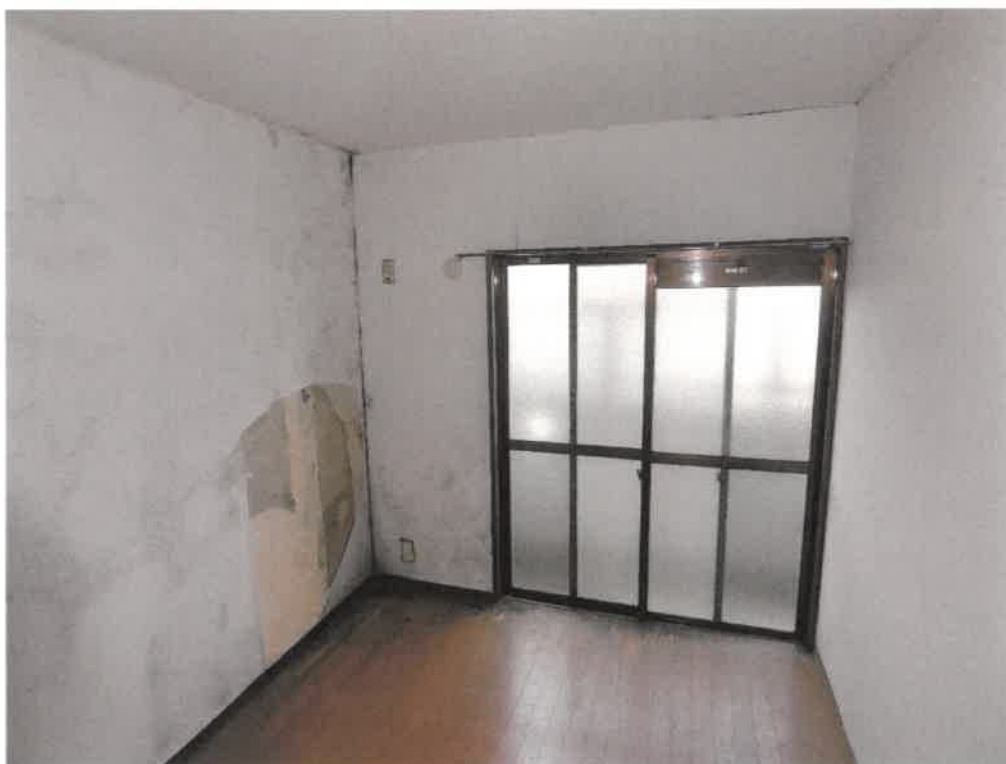
8 物件2建物内部の状況（N棟203号室・洋室1）
