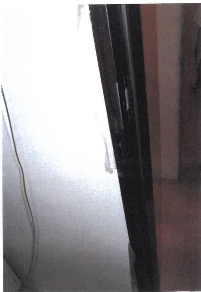
⑧ 屋内の状況（洋室1）
