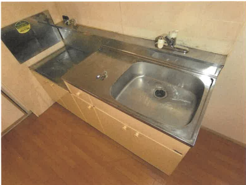
6 物件2建物内部の状況（101号室・キッチンシンク）
