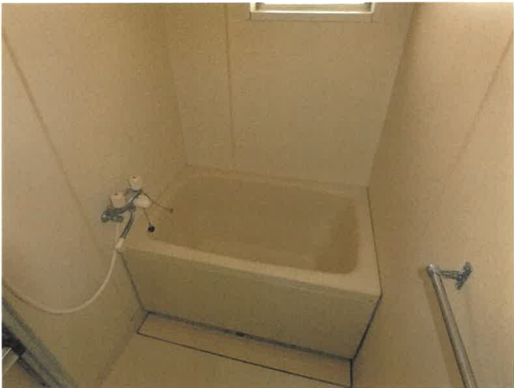
8 物件2建物内部の状況（101号室・浴室）
