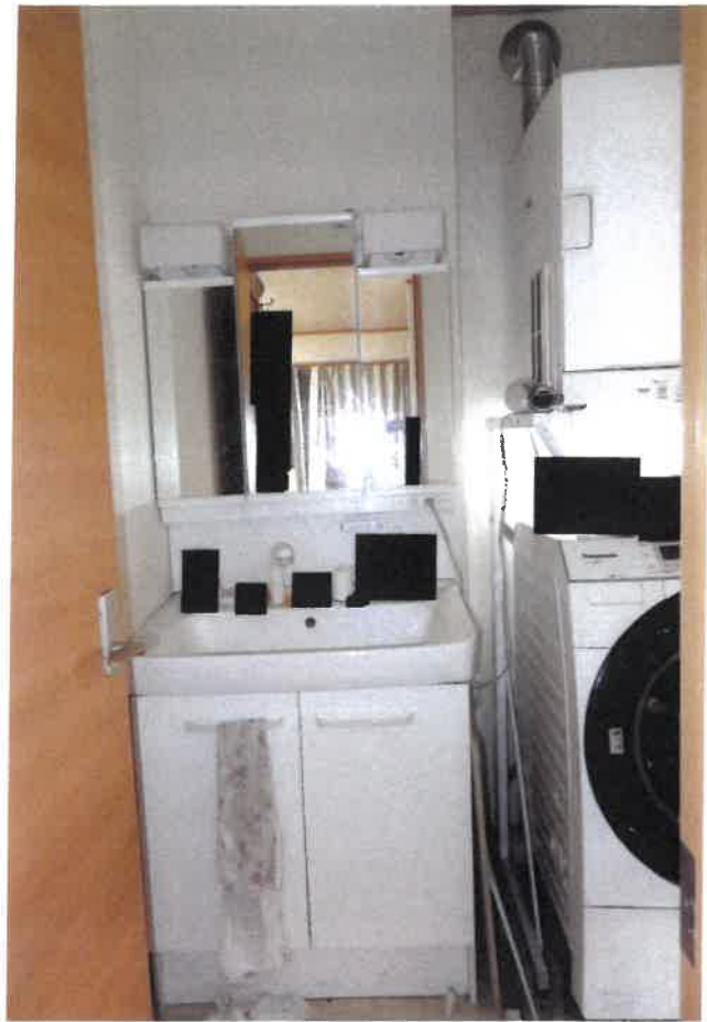
⑦ 屋内の状況（洗面所の様子）
