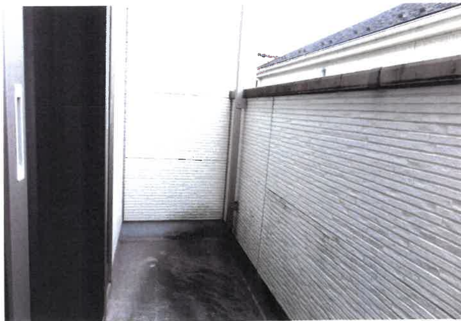
⑧ 屋内の状況（ベランダの様子）
