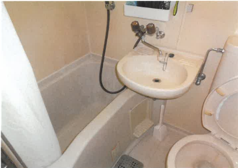
屋内の状況 浴室
