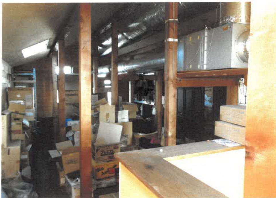
⑪ 3階機械室の状況
