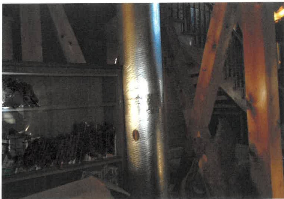
⑨ リビングのパイプの状況
