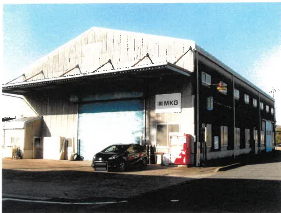
① 物件1 土地を含む物件3 建物の外観
