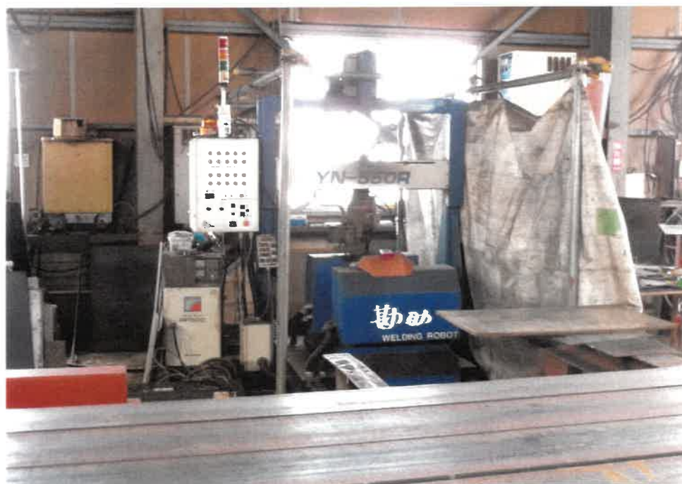
⑧ 物件3建物内の工業機械3
