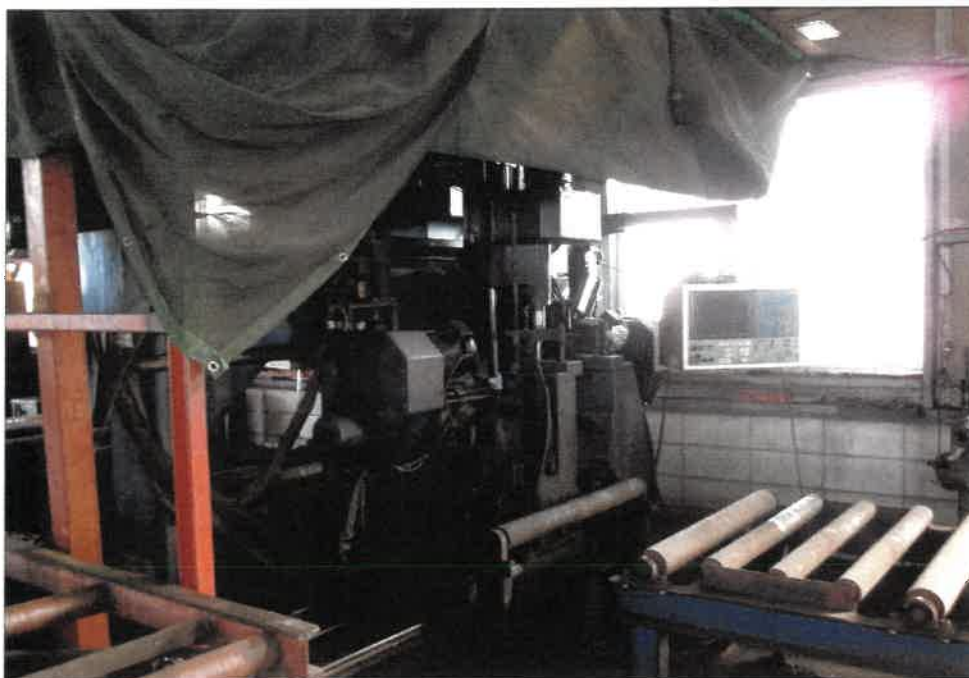
⑦ 物件3建物内の工業機械2
