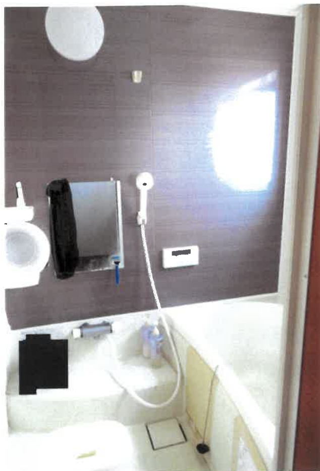
⑥ 屋内の状況（浴室）
