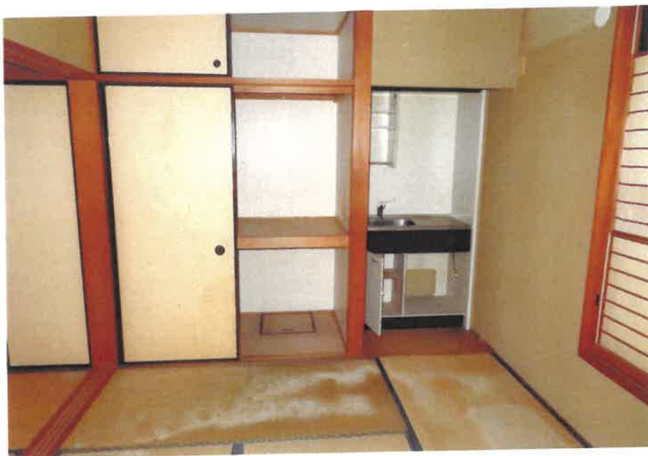
③ 屋内の状況（和室①）
