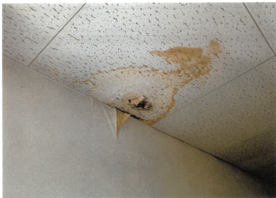
④ 事務室4天井の状況
