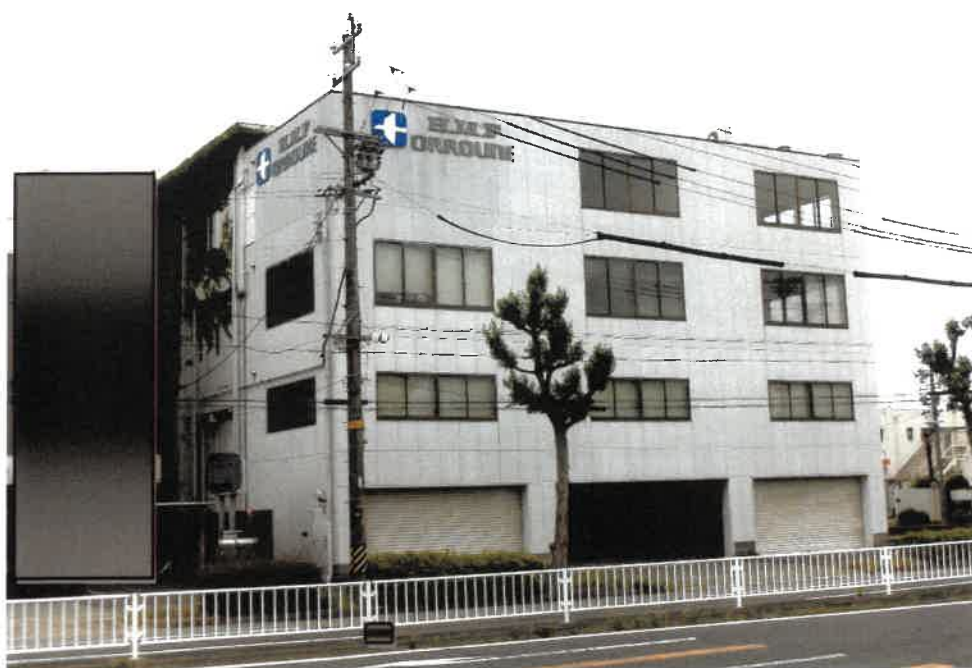
① 物件 1 土地及び物件 2 土地を含む物件 4 建物の外観
