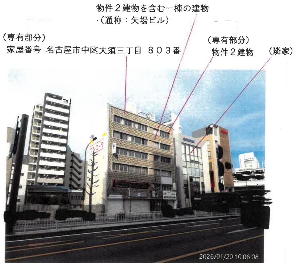
1 南東方向から撮影
