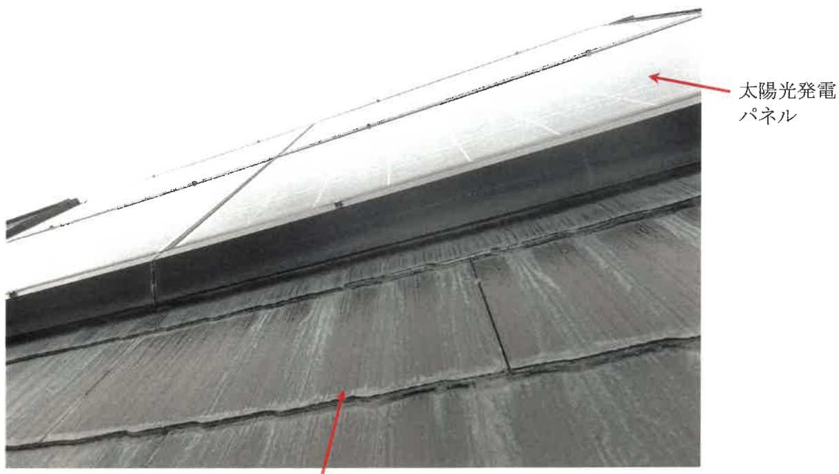
物件2建物の屋根
