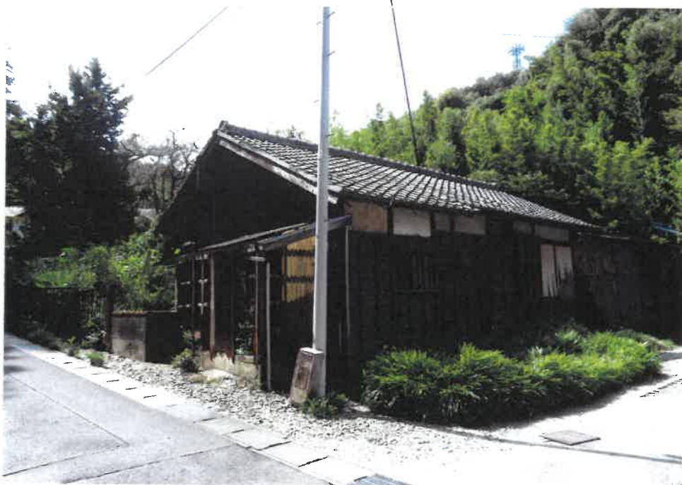
② 北西方向から撮影
