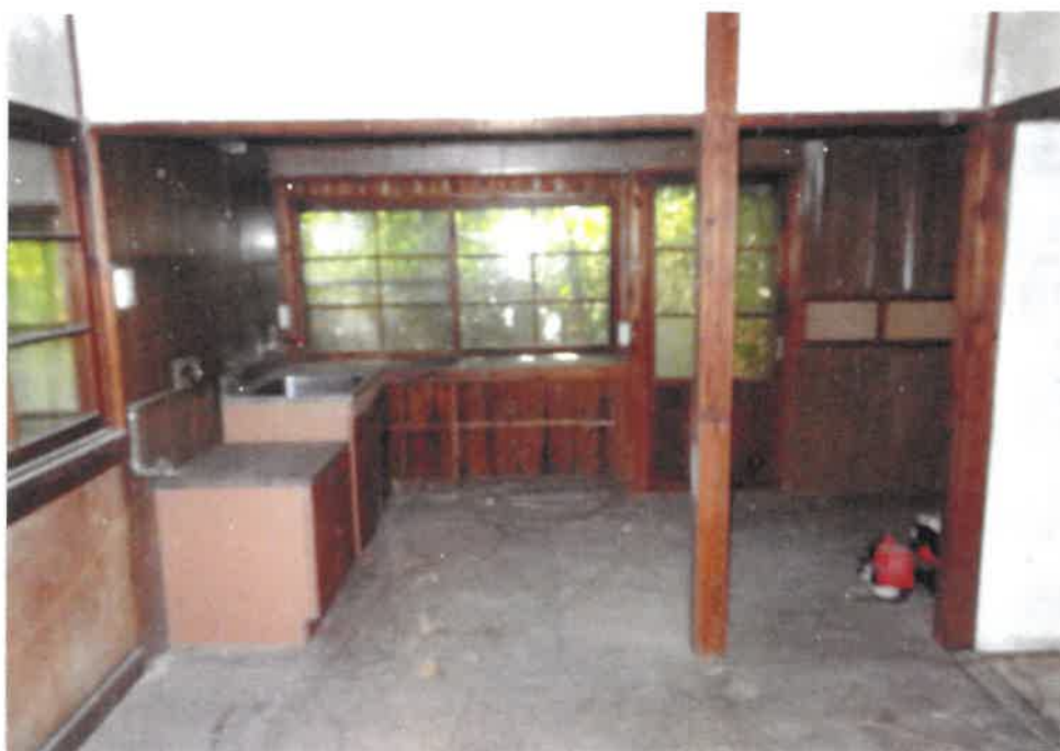
⑨ 屋内の状況（物件１４主である建物キッチンの様子）
