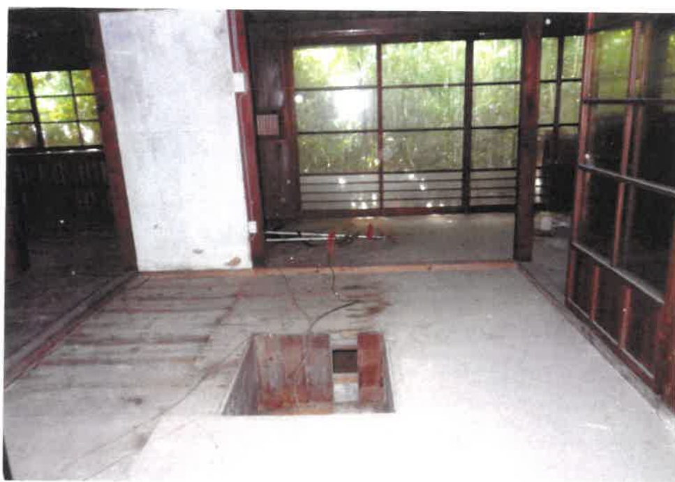
⑩ 屋内の状況（物件１４主である建物(旧)和室の囲炉裏の様子）
