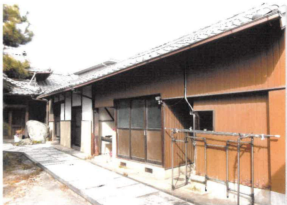
④ 物件4土地を含む物件5建物（附属建物符号1）の外観
