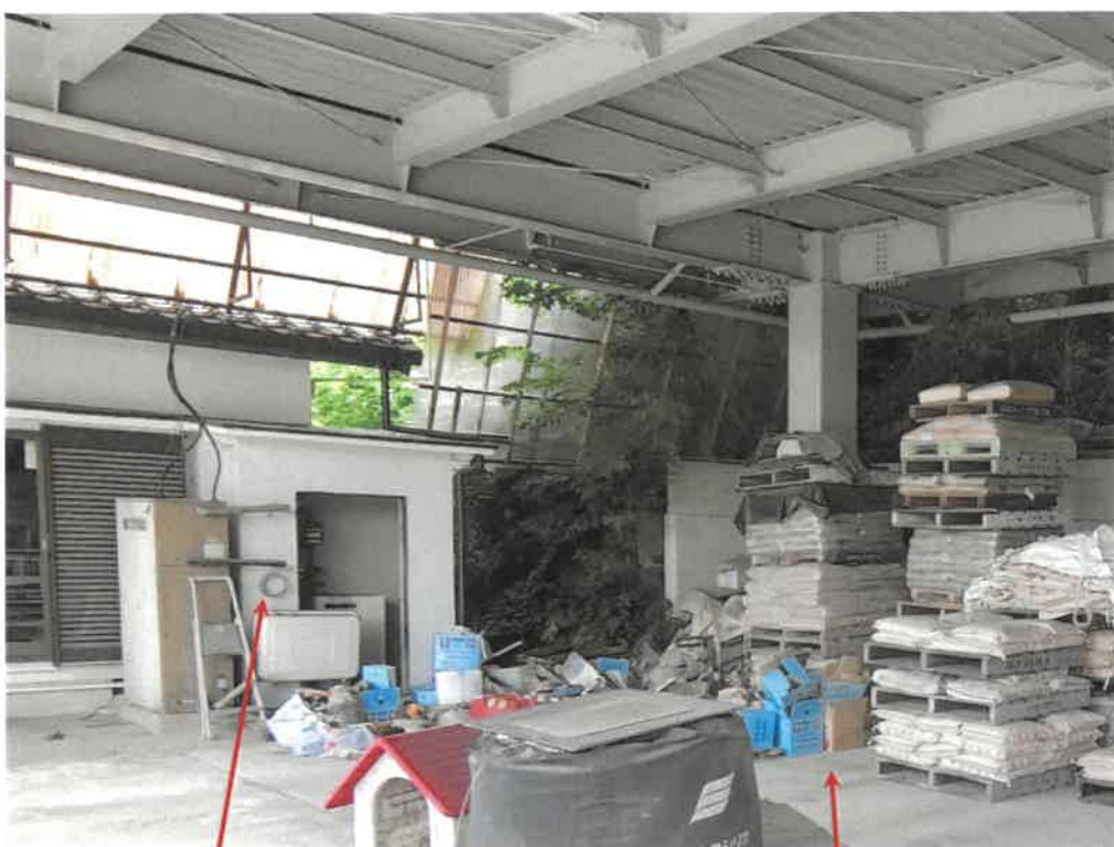
物件4建物増築部分
