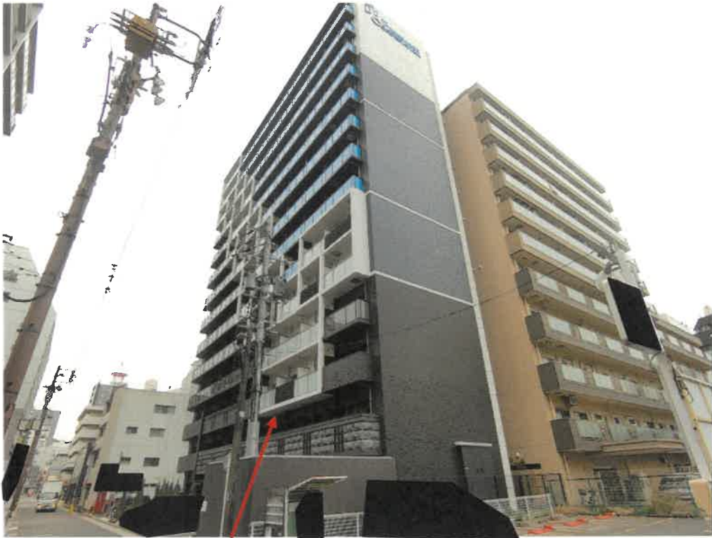
物件1建物を含む一棟の建物 (プレサンスSAKAEフロント)
