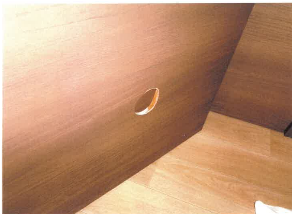
⑥ 洗面室の扉の状況
