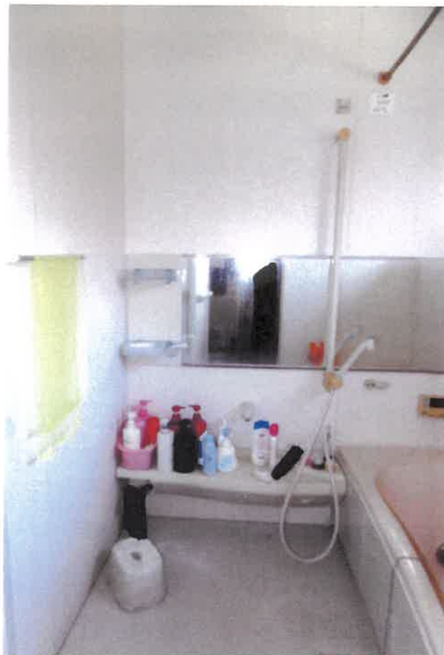
⑩ 屋内の状況（浴室）
