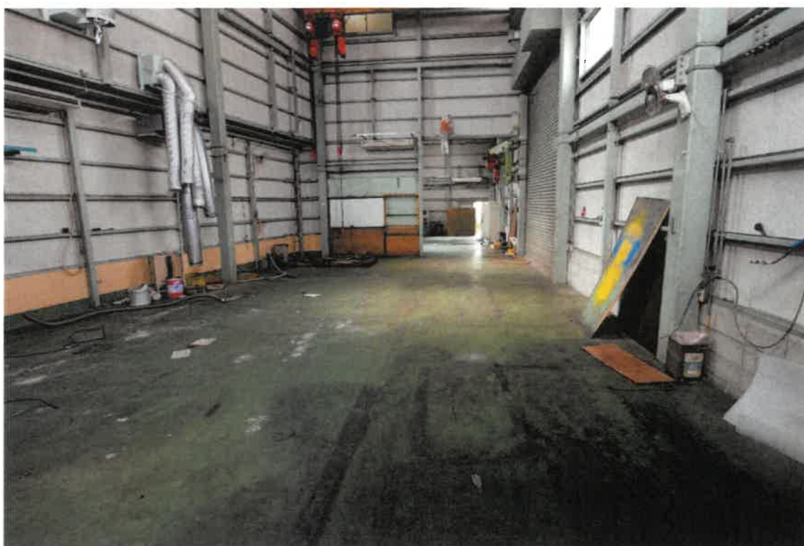
写真2 物件6 主建物 1階室内(作業場2～作業場1)
