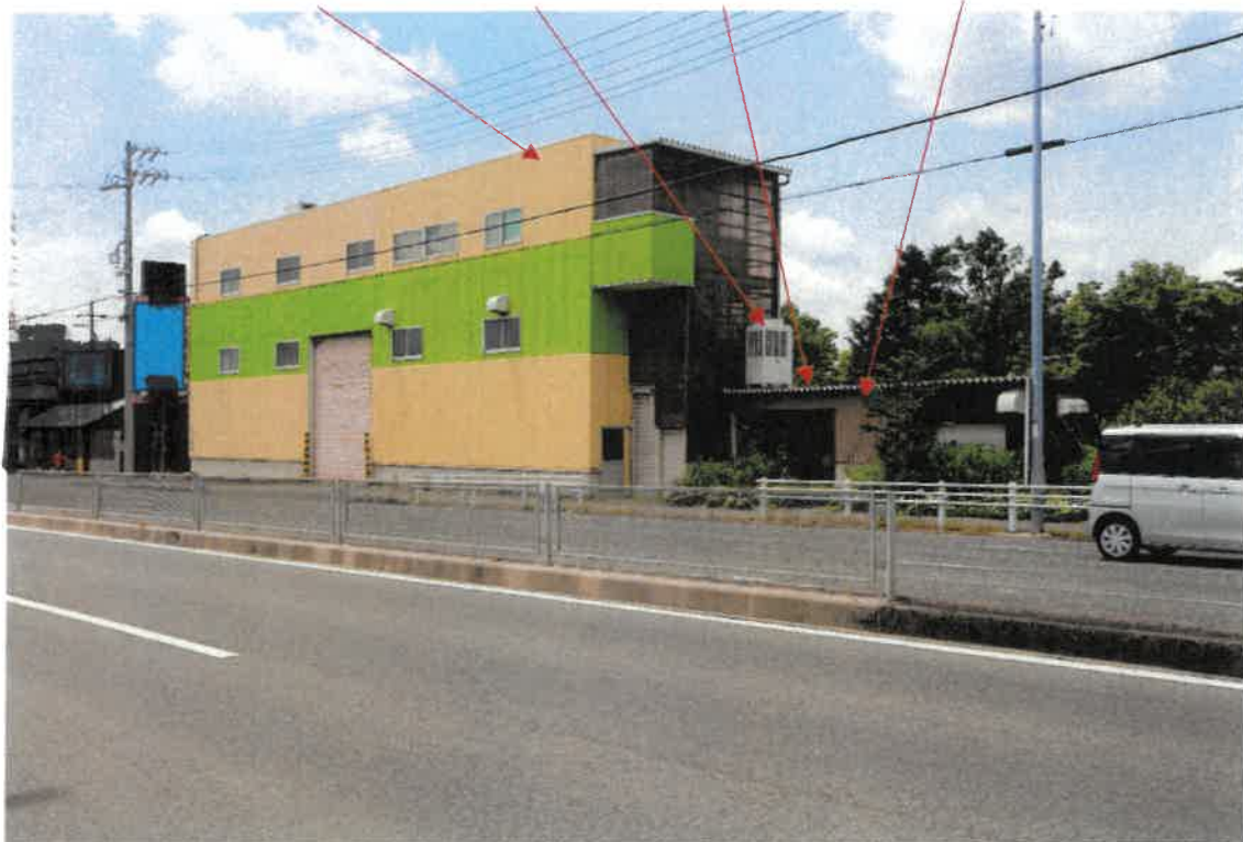
写真1 物件6 主建物 室外機 差掛け 物件6 未登記増築部分
