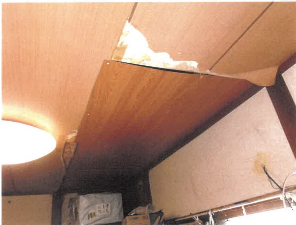
④ 和室1天井の状況
