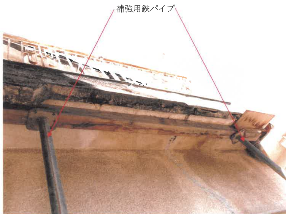
⑧ バルコニー補強の状況
