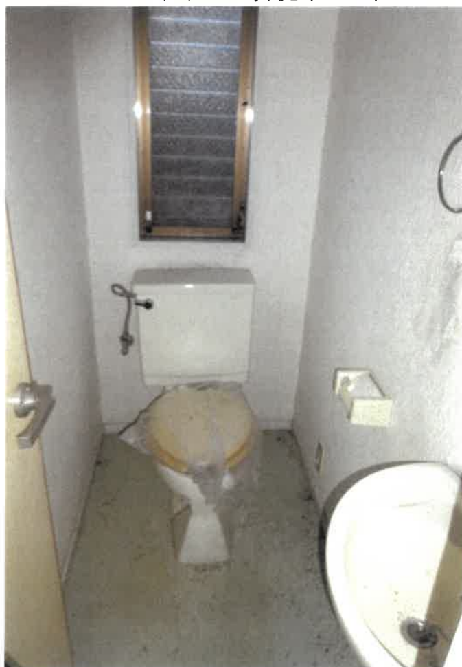
トイレの状況(101)
