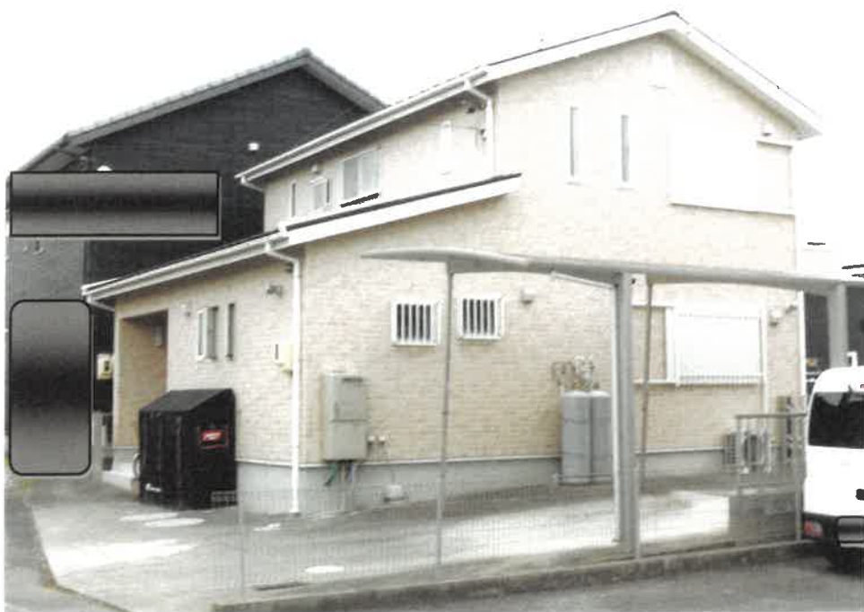
① 物件1 土地及び物件2 土地を含む物件3 建物の外観
