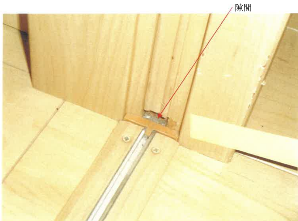
⑨ リビング・ダイニング扉戸当たりの状況
