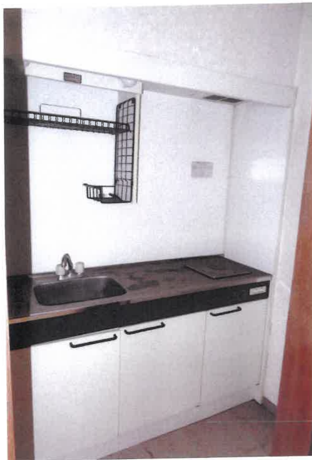
⑤ 屋内の状況（給湯室の様子）
