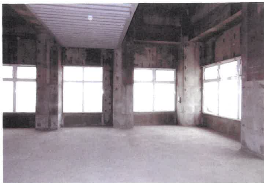
④ 屋内の状況（スケルトンの様子）
