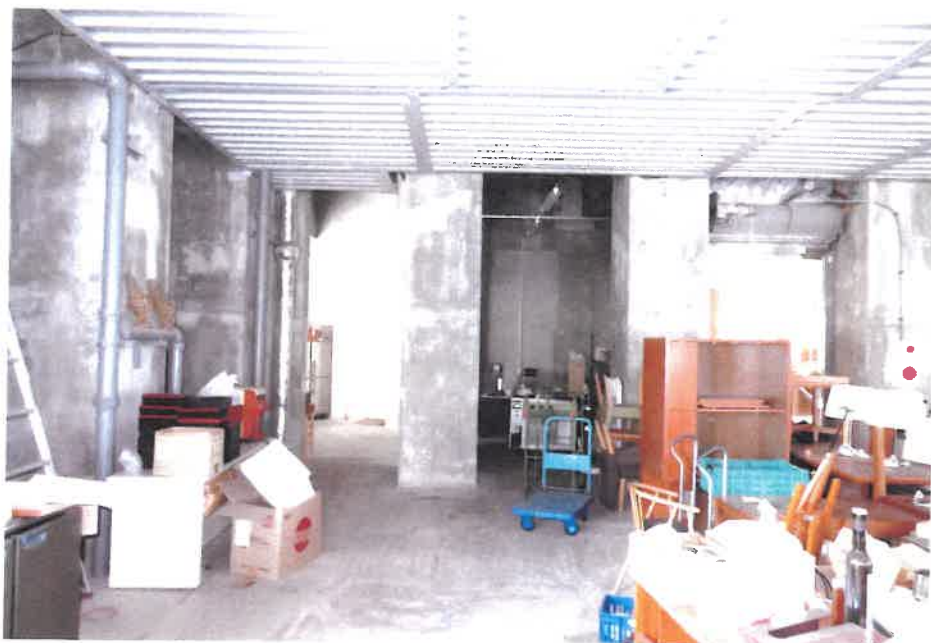
③ 屋内の状況（残置物の様子）
