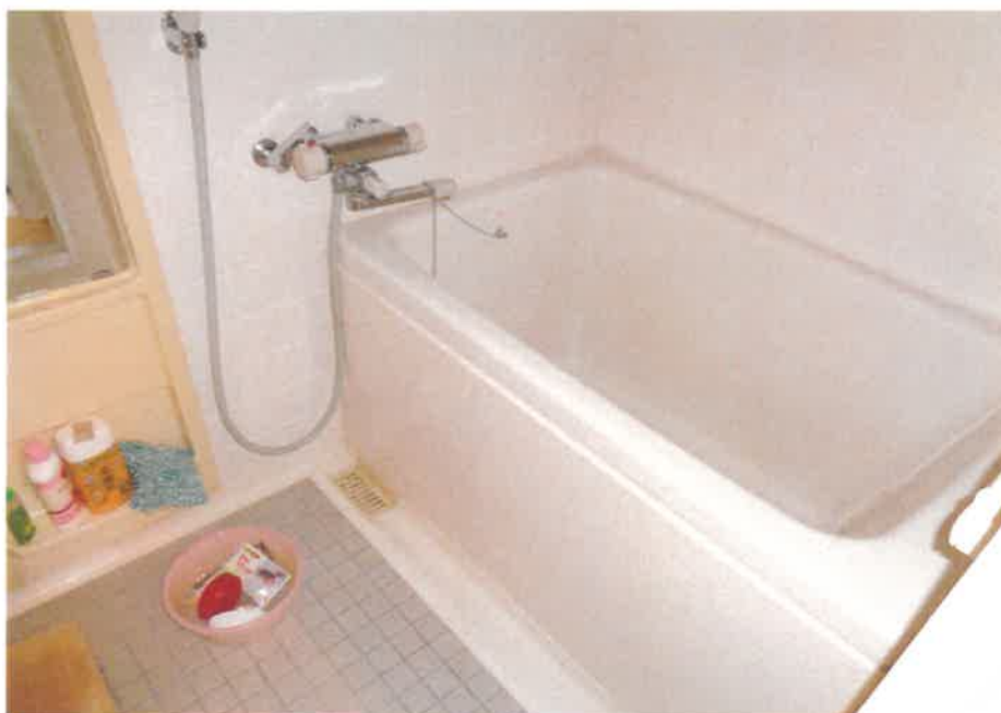
屋内の状況 浴室
