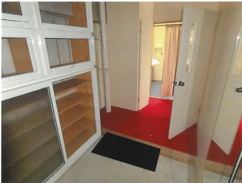
7 物件4建物内部の状況（上がり框（パイプ周辺））
