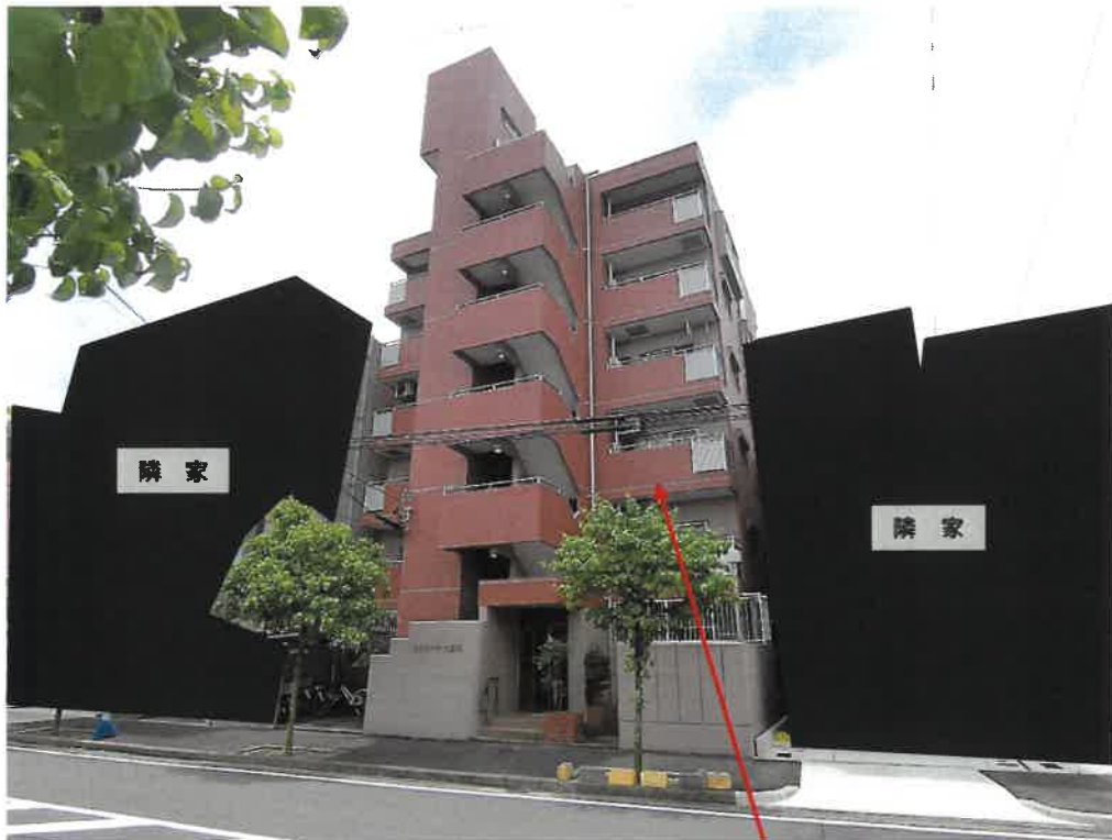
物件4建物を含む一棟の建物 (ネオカーサ大曽根)
