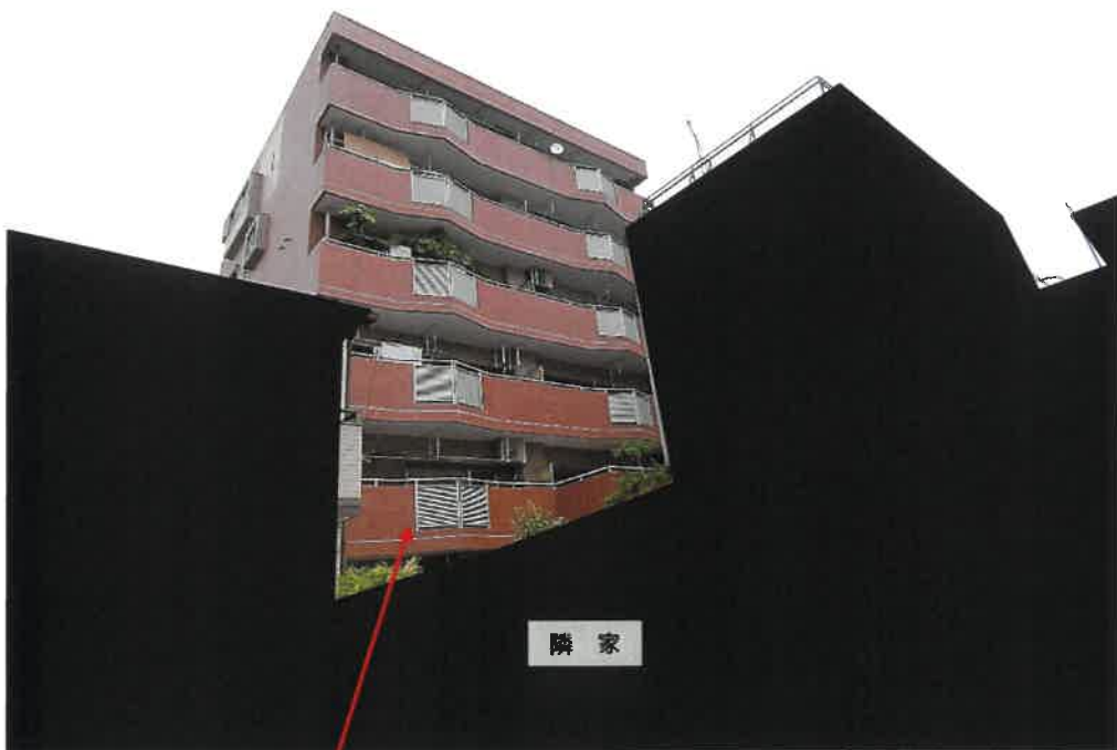
物件4建物を含む一棟の建物 (ネオカーサ大曽根)
