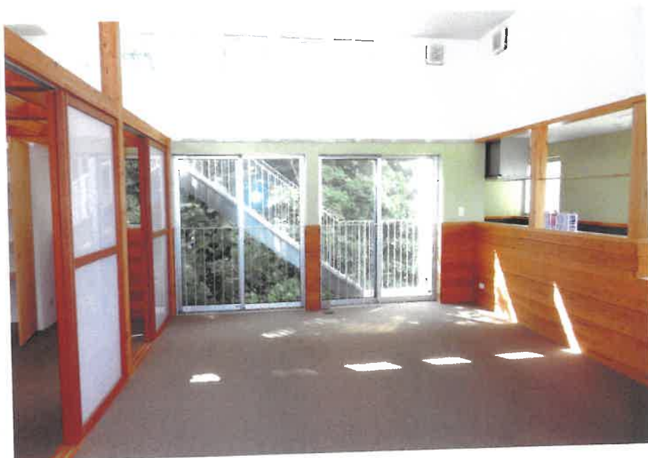
⑤ 屋内の状況（作業室3）
