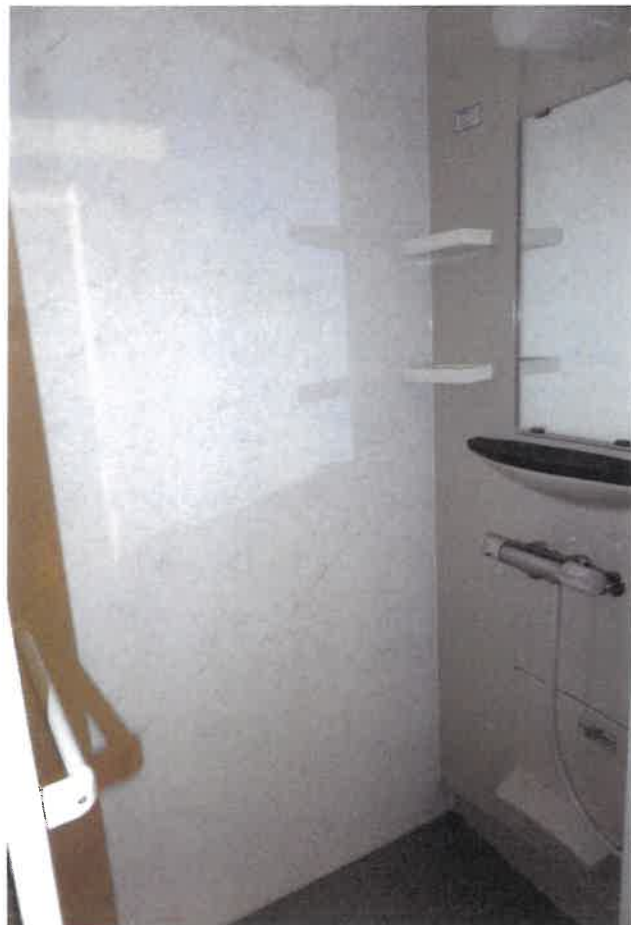
⑩ 屋内の状況（シャワー室）
