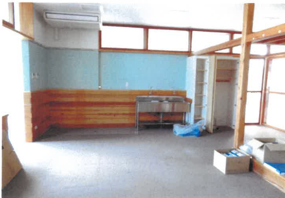
② 屋内の状況 (作業室 1)
