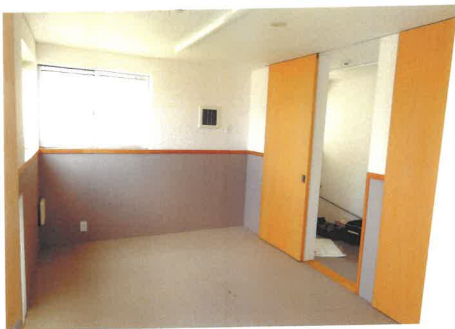
⑦ 屋内の状況（休憩室）
