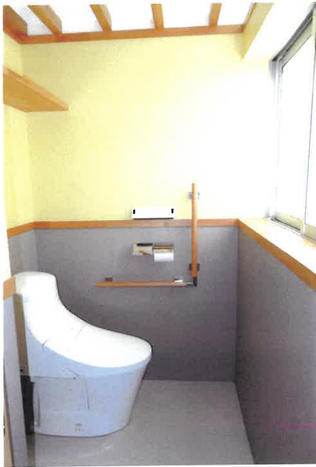
⑨ 屋内の状況（1階北側便所）
