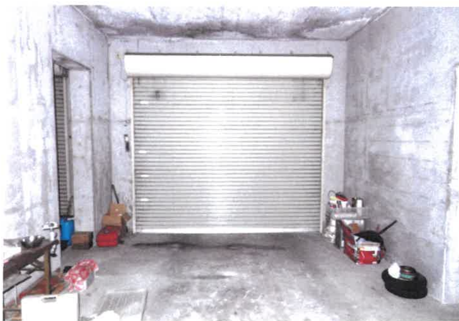
② 屋内の状況 (車庫2)
