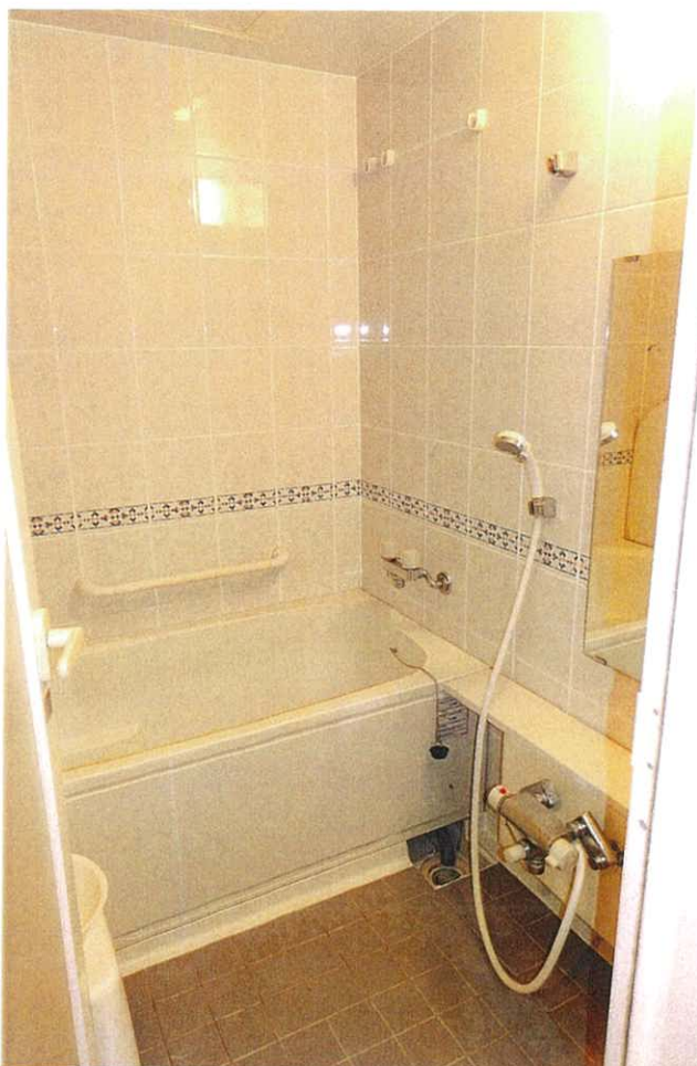
⑥ 屋内の状況（浴室）
