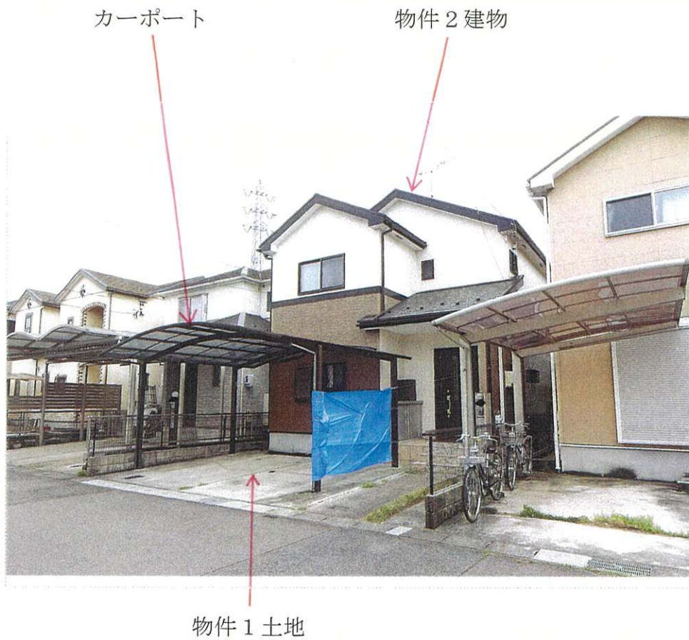
① 物件1土地、物件2建物の外観（北西方向から撮影）
