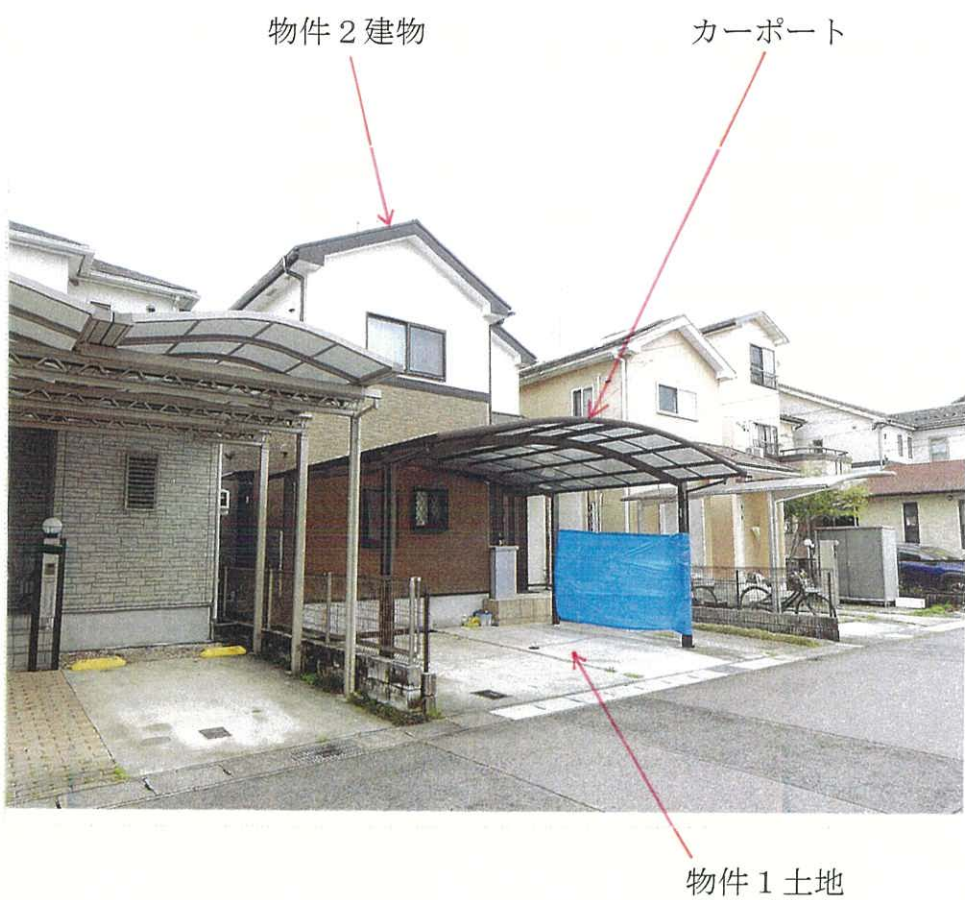
② 物件1土地、物件2建物の外観（北東方向から撮影）
