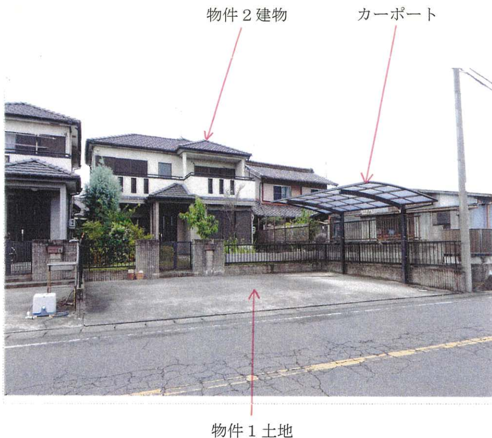
① 物件1 土地、物件2 建物の外観
