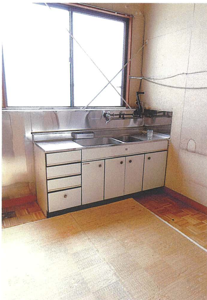
⑥ 屋内の状況（給湯室２）
