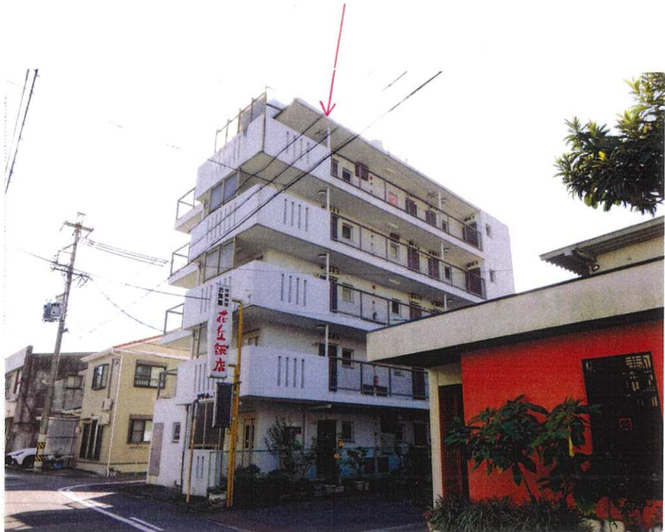
物件1 建物を含む一棟の建物
