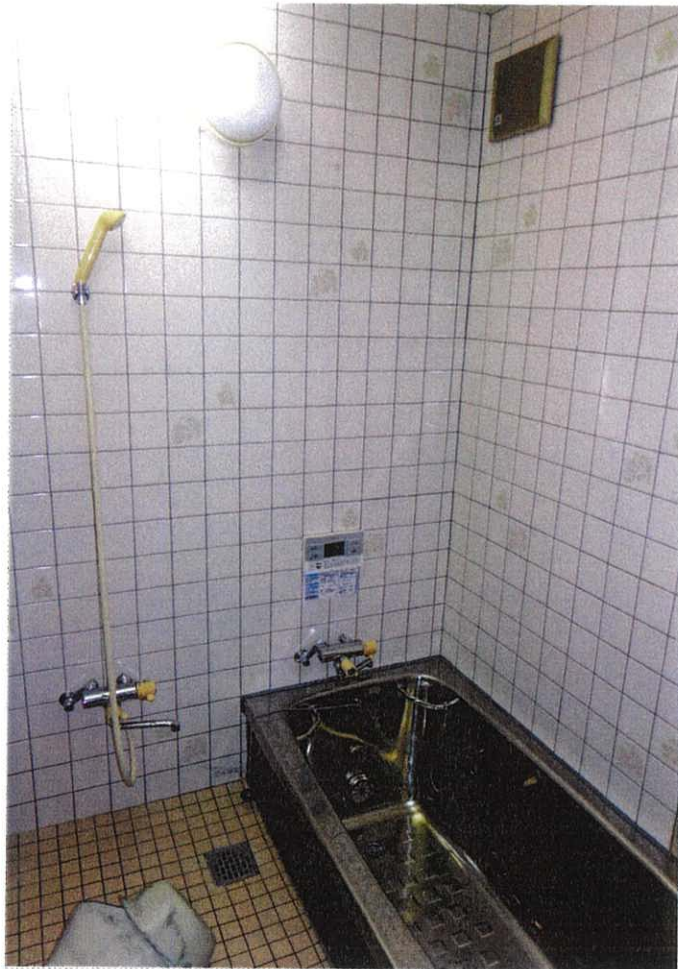
⑦ 浴室（主である建物）
